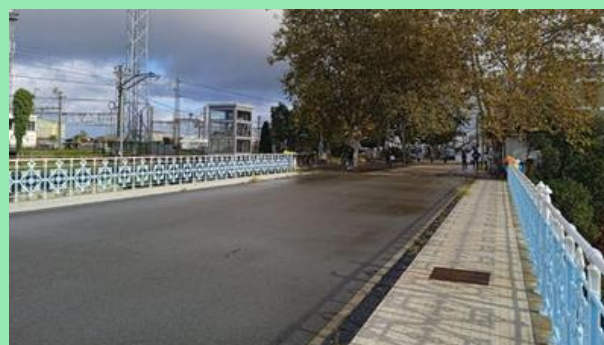
UNA FOTO ACTUAL DEL PUENTE
